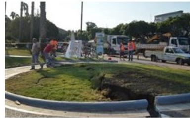
Μικρή πλατεία έχει ανοίξει στα δύο, μετά το σεισμό μεγέθους 6,4 ρίχτερ που σημειώθηκε στο νησί, Παρασκευή 21 Ιουλίου 2017.
